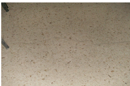
Fisuras Pisos Edificio Administrativo
